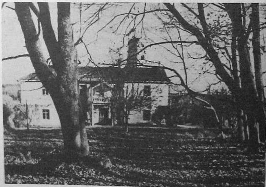
163. Przyluki. Budynek administracji, ok. 1914 r.
